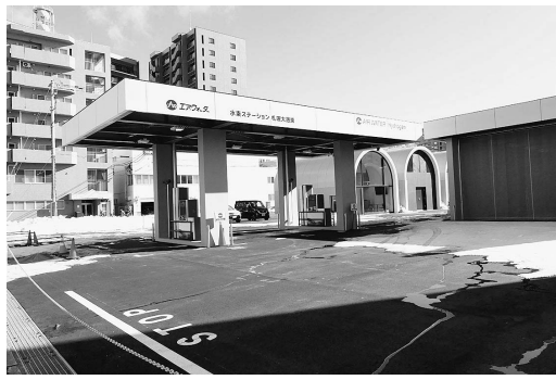
水素ステーション札幌大通東
